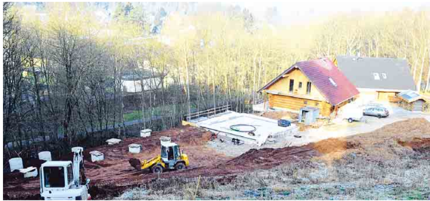
Die teilweise fertiggestellte Ferienanlage bei Gemünd nimmt mit dem ersten 4-Sterne-Haus Ostern den Betrieb auf.
